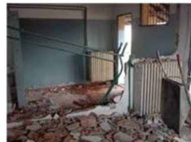
DEMOLIZIONI E SMONTAGGI
