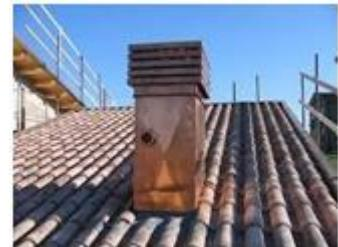
Per la realizzazione di comignoli su coperture esistenti, si rendono necessari interventi di taglio del solaio esistente per l'attacco con la canna fumaria, previa rimozione del tegolato e degli strati di impermeabilizzazione e coibentazione; a posa in opera completata, è necessario ripristinare nell'intorno del comignolo, gli strati di protezione e copertura, senza creare discontinuità con la parte esistente ed eseguendo il lavoro a regola d'arte.
