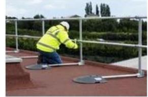
Un parapetto provvisorio è costituito da un montante, un corrente principale, un corrente intermedio e un corrente inferiore.
