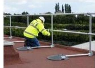
Un parapetto provvisorio è costituito da un montante, un corrente principale, un corrente intermedio e un corrente inferiore.
