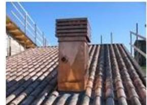
Per la realizzazione di comignoli su coperture esistenti, si rendono necessari interventi di taglio del solaio esistente per l'attacco con la canna fumaria, previa rimozione del tegolato e degli strati di impermeabilizzazione e coibentazione; a posa in opera completata, è necessario ripristinare nell'intorno del comignolo, gli strati di protezione e copertura, senza creare discontinuità con la parte esistente ed eseguendo il lavoro a regola d'arte.
